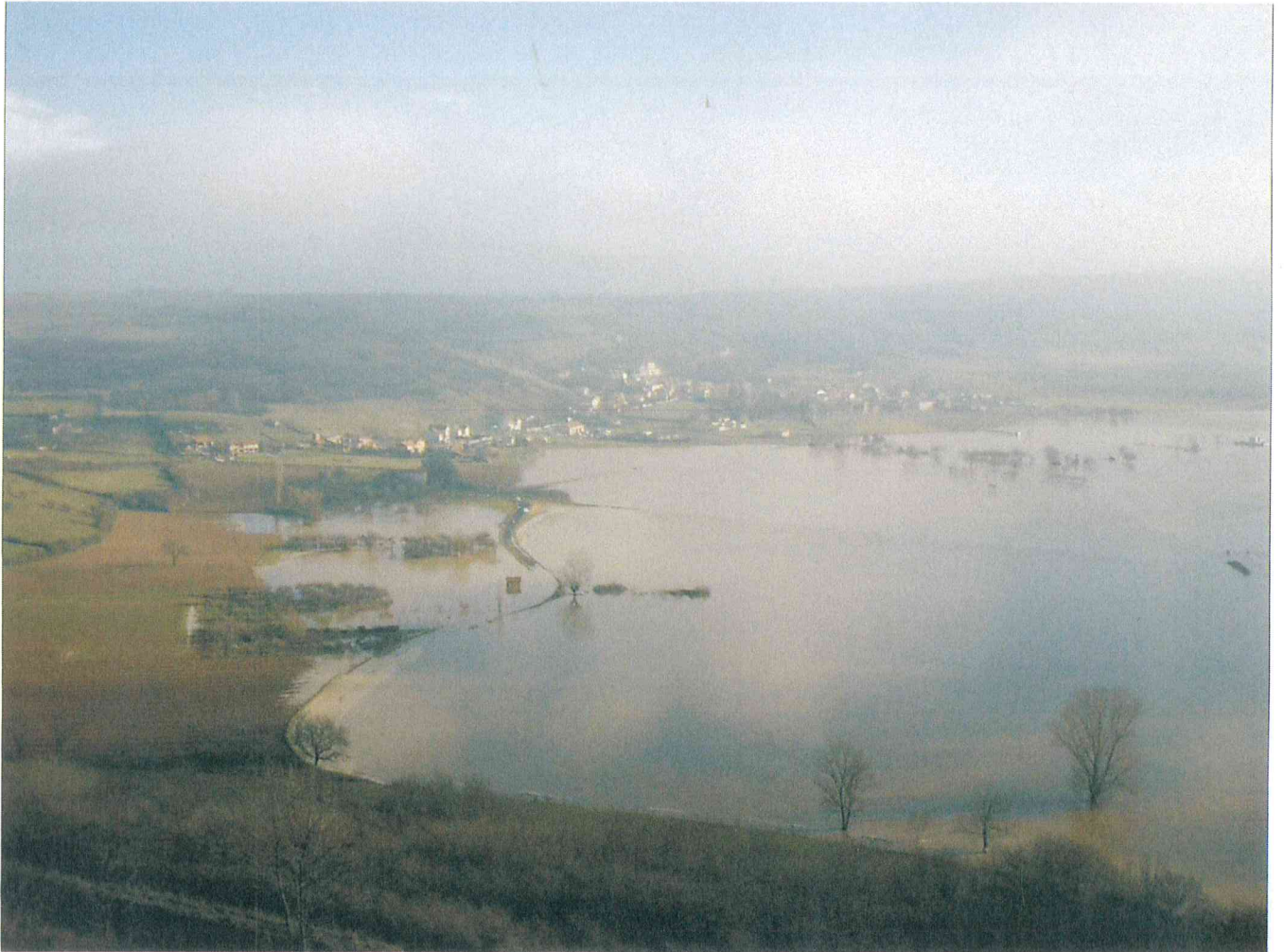
Inondation du 4 décembre 2003 -vue de Nonette-Orsonnette.
